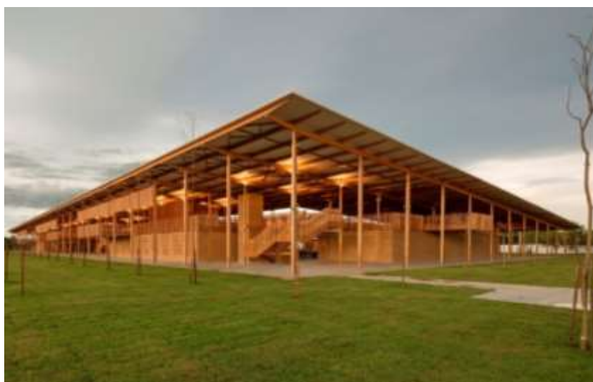
Figura 01 – Vista da edificação
